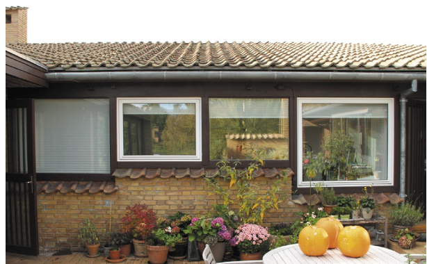
Vinduer og op- og nedtrappet murværk med den karakteristiske teglsålbænk i værelsesfløjen.
