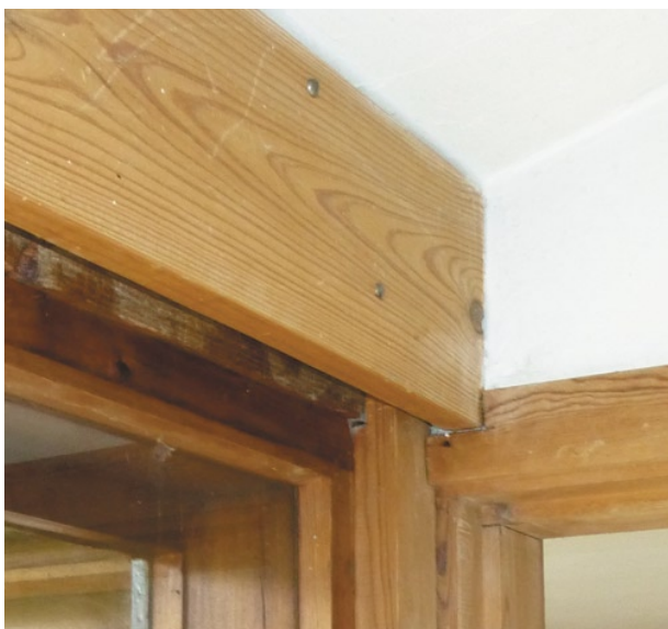
Dækpladen er monteret med synlige skruer over vinduer i alle rum med undtagelse af køkken og bad.
