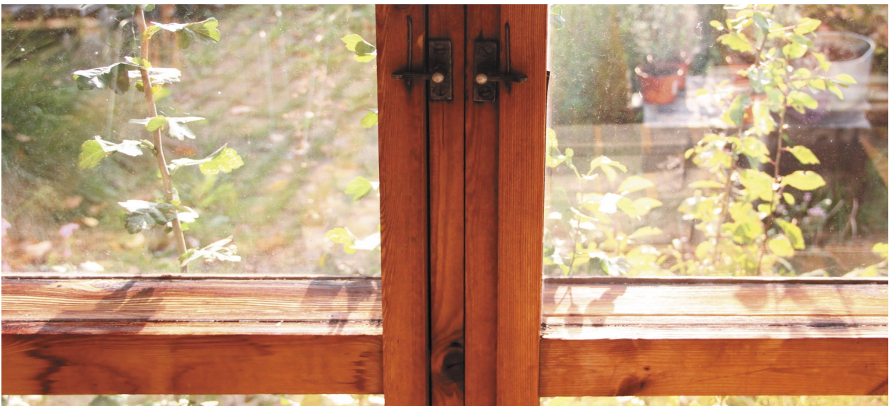
Oprindeligt vinduesparti med forsatsrammer og vridere i opholdsrummet.
