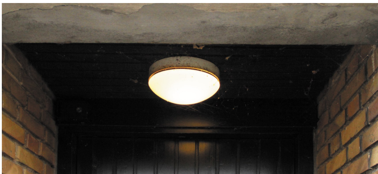
Den oprindelige hoveddørslampe. Under registreringerne har det vist sig, at størstedelen af husene stadig har den oprindelige belysning ved hoveddøren. Lampen består af en rund fod og en matteret kegleformet glaskuppel.
