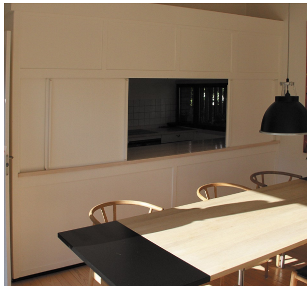
Bordpladen i køkkenet er højere end i det oprindelige køkken. På billedet t.v. er møbelvæggens vandrette liste i den forbindelse gjort højere, så bordpladens bagkant skjules. På billedet til t.h. er det løst ved at føre bordpladens bagkant frem på møbelvæggen og føre skydelågerne heri.
