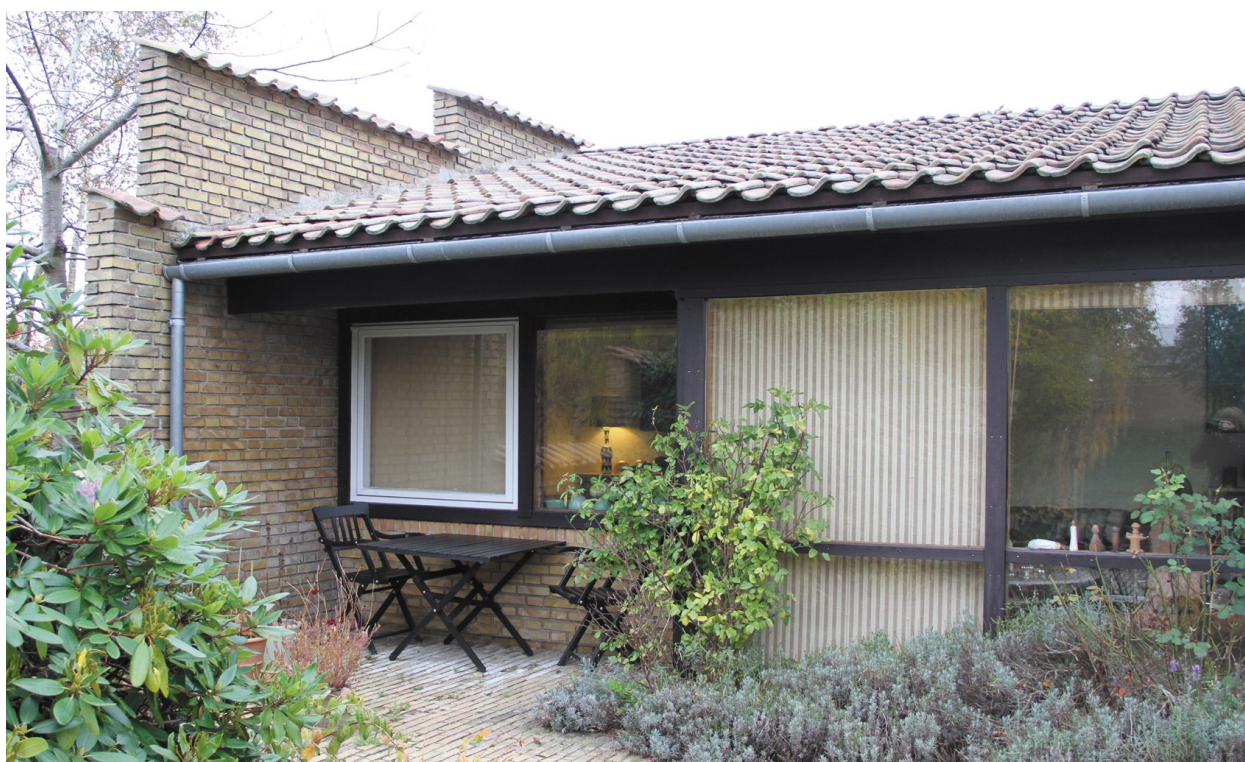
Værelset for enden af opholdsrummet ligger tilbagetrukket i forhold til opholdsrummets vinduesparti, der går fra gulv til loft.
