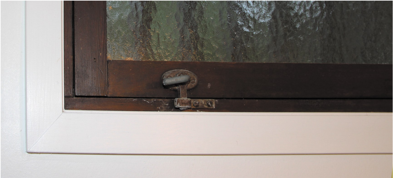
Beslag og indfatning i badeværelse. Det spinkle beslag og den smalle listeindfatning er anvendt på de oprindelige vinduer i køkken og bad.
