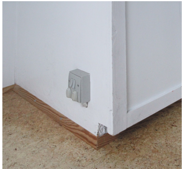
Møbelvæggens sokkel er trukket tilbage fra fronten. En detalje, der bidrager til møbelvæggens lethed og underbygger dens status som et møbel
