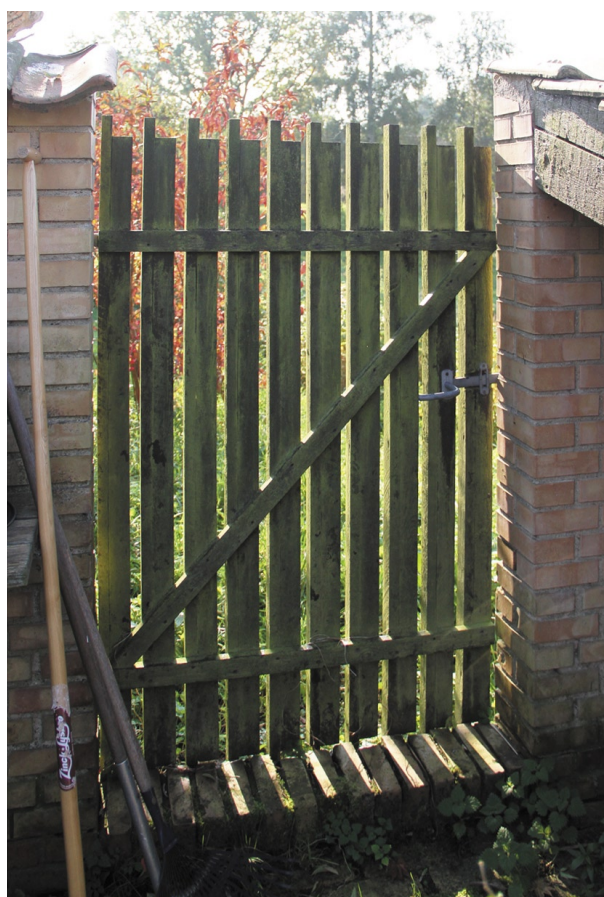
Havelågen hængsles direkte i murværket uden brug af karme.
