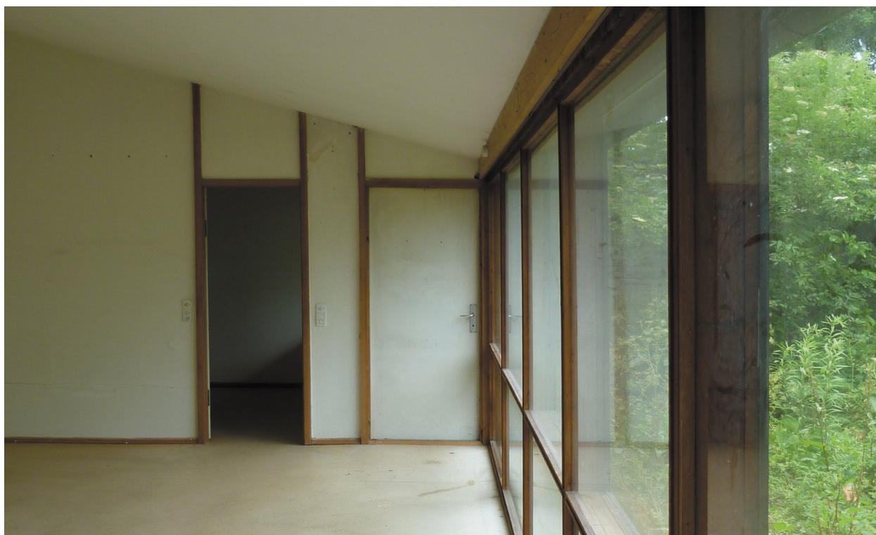
Enkle overflader. Pudsede vægge og lofter, linoleum på gulvet. De lodrette gerichter går til loft, hvorved vægfladen opdeles i store felter.
