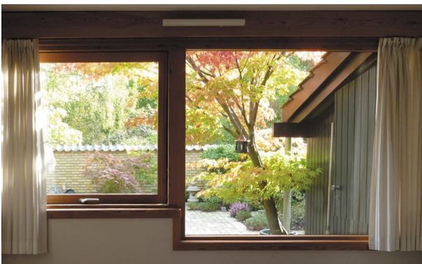
Indvendigt vinduesparti i værelse. Vinduesplade og træindfatning følger murværkets op- og nedtrapping.
