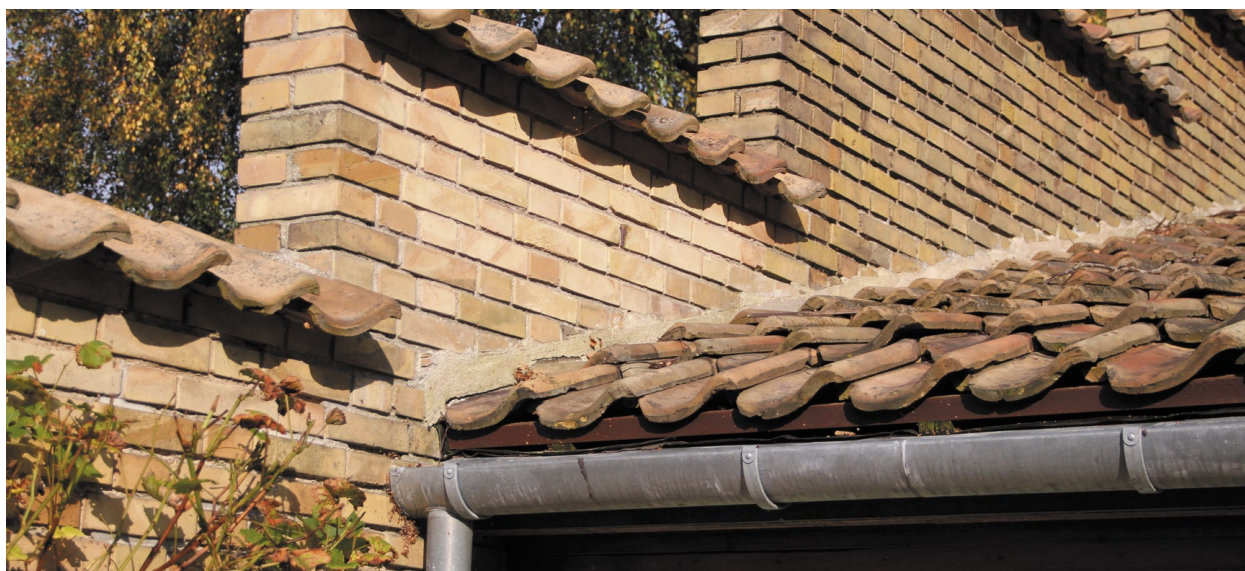
Tagfladen afsluttes med mørtelforskelling mod lodret murværk. Der anvendes ikke metalinddækninger. Sternens afsluttes med tagrende i zink.
