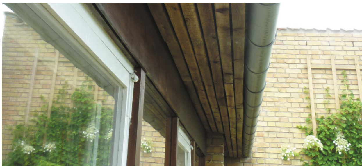
Udhænget beklædes på undersiden med smalle udhængsbrædder, som placeres med mellemrum for at sikre ventilation af tagkonstruktionen.
