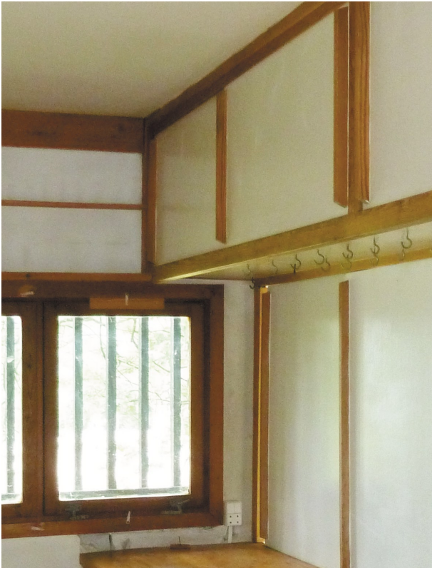
Overskabet er placeret over vinduesindfatningens overkant.
