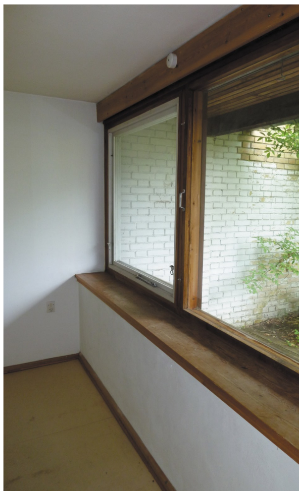
Den dybe vinduesplade i værelset for enden af opholdsrummet. Romerhusene blev oprindeligt opført med pudsede vægge og lofter og linoleum eller kork på gulvene.
