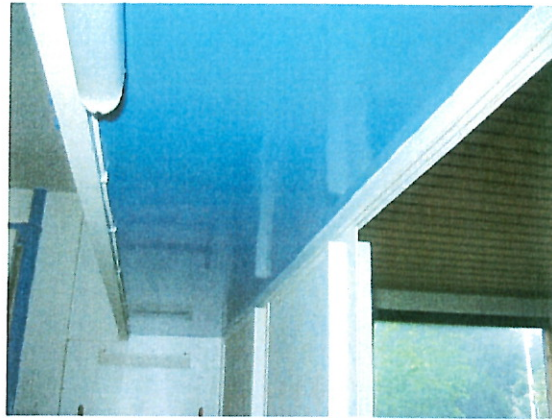
Overskab ved væg mod stuen, med åben skydelåge nedenunder
