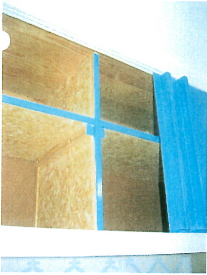
Overskab ved væg mod stuen
