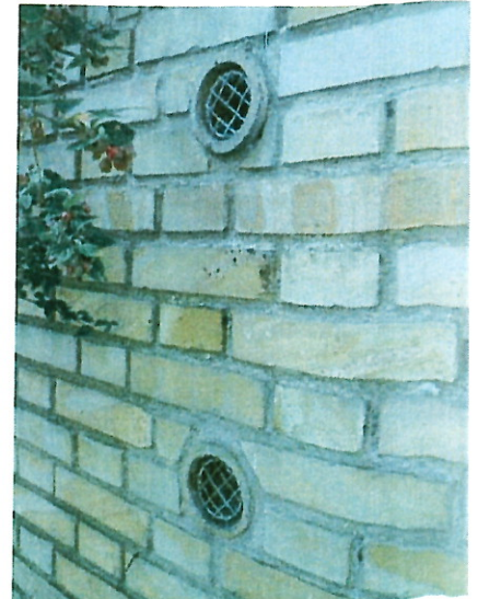
"Køleskabs" ventilation synlig facaden
