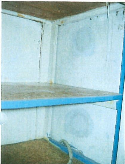
Underskab ved væg mod stuen: Tilmurede åbninger i "køleskab"
