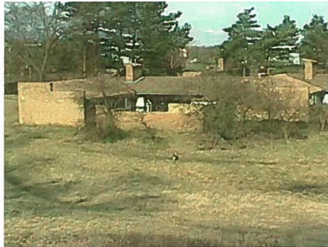
Dalen fra Baggesensvej mod Carl Plougs Vej
